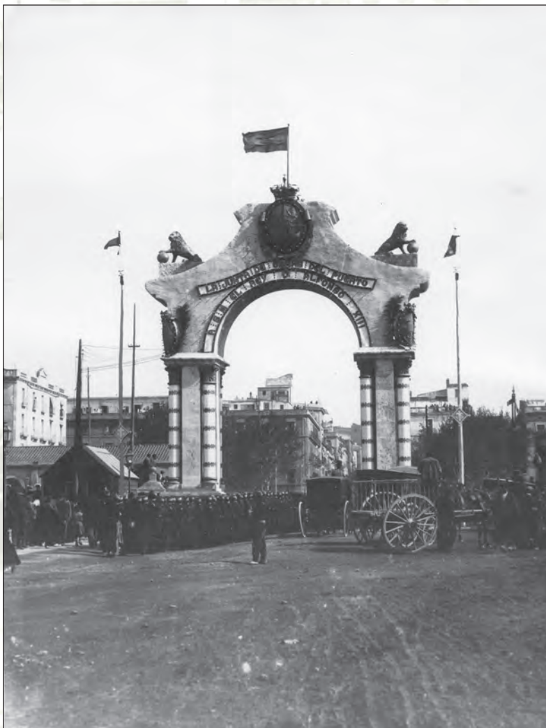
Plaça dels Carros (Plaça Olózaga) amb l'arc que les Obres del Port li va dedicar obra de l'escultor Fèlix Ribas.
